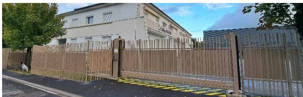
Sécurisation des accès du collège Mathalin à Auch
