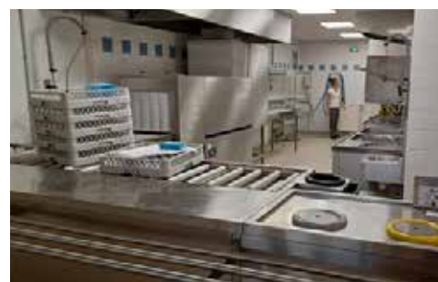
Rénovation des laveries des services de restauration des collèges
