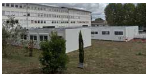
Les locaux modulaires du collège de Fleurance en attendant la reconstruction de la toiture
