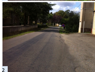
1 RD 157 avant travaux 2 Devant salle des fêtes avant travaux
